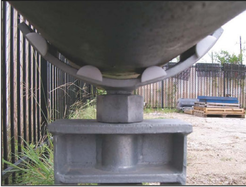
التركيب يمكن ربط I-Clip باستخدام شريط لاصق للمساعدة أثناء عملية التركيب.
