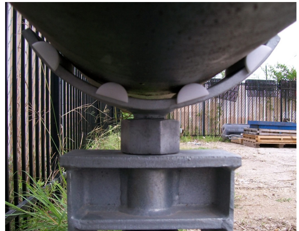
Pemasangan I-Clip boleh dipasang dengan pita perekat untuk membantu semasa pemasangan
