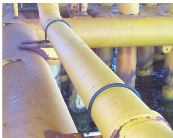
Offshore Nu-Bolt su percorso di tubazione (+) 10'0" di elevazione su piattaforma offshore.
