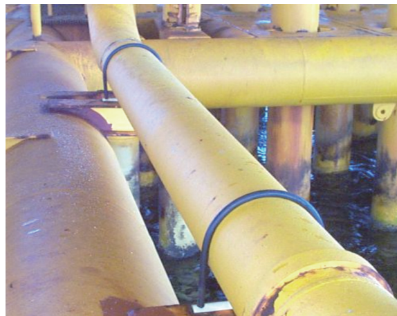
Offshore Nu-Bolts em tubos com elevação de (+) 3 m (10'0") em uma plataforma offshore.
