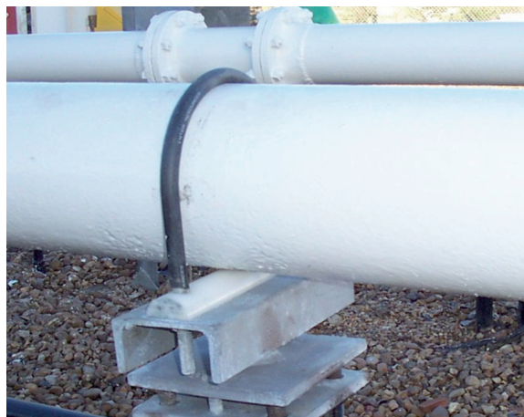
Offshore Nu-Bolts em tubos com elevação de (+) 3 m (10'0") em uma plataforma offshore.
