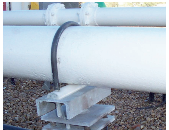
Entornos marinos Nu-Bolts en tramos de tuberías en elevaciones de (+) 10'0" en una plataforma marina.
