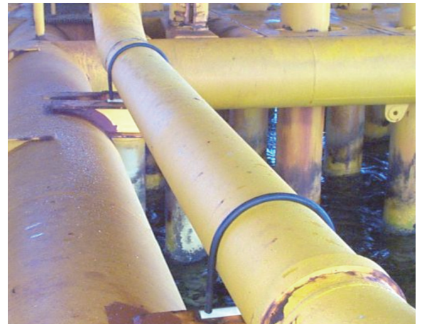
Entornos marinos Nu-Bolts en tramos de tuberías en elevaciones de (+) 10'0" en una plataforma marina.
