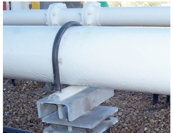
Costa afuera Nu-bolt en sección de tubería en la elevación (+) 10'0" en una plataforma costa afuera.
