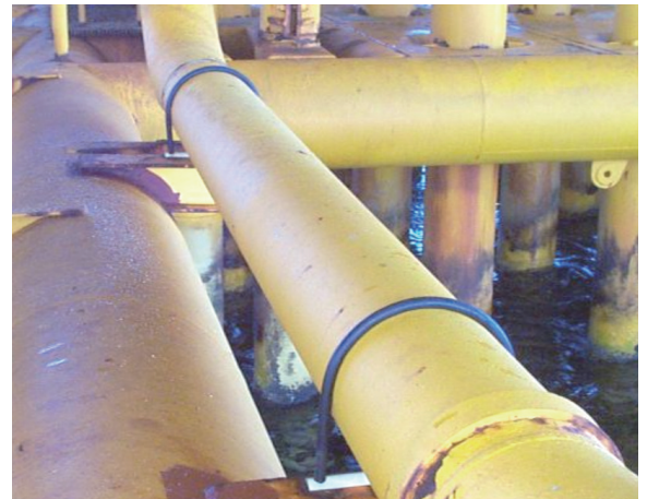
Costa afuera Nu-bolt en sección de tubería en la elevación (+) 10'0" en una plataforma costa afuera.
