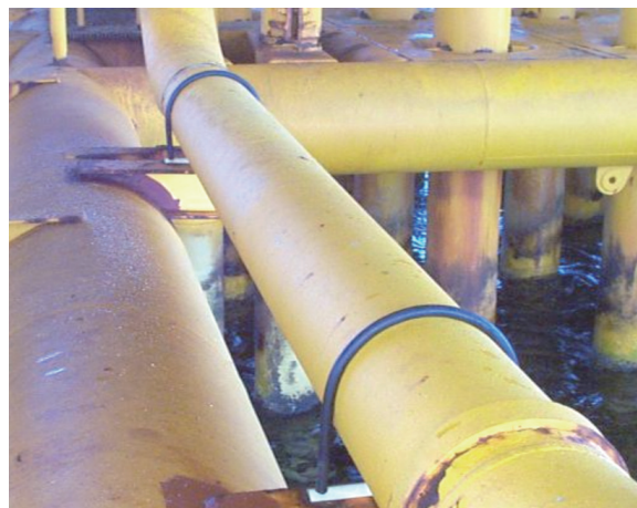
Costa afuera Nu-bolt en sección de tubería en la elevación (+) 10'0\"/>
