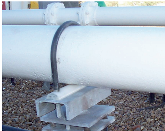
Costa afuera Nu-bolt en sección de tubería en la elevación (+) 10'0\"/>
