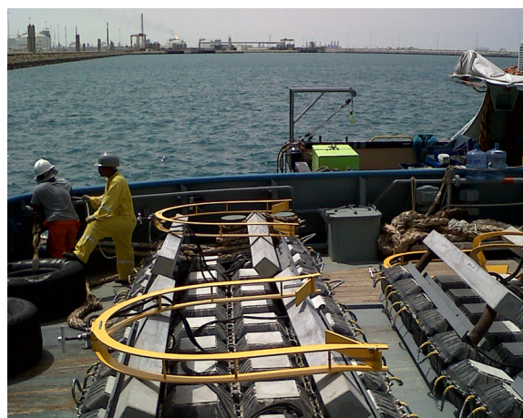
卡塔尔 本工程的铝阳极浇筑在 RetroMat 外侧。
