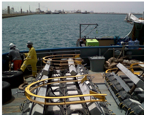
Qatar Os ânodos de alumínio usados nesse serviço foram fundidos fora dos RetroMats.
