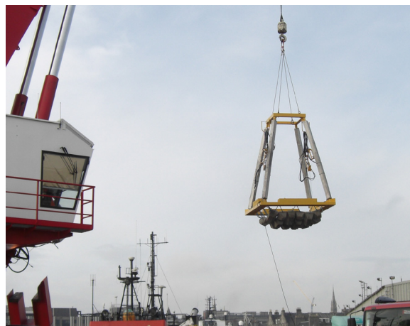
北海 RetroPod 部署作为北海牺牲阳极改造工程的一部分。
