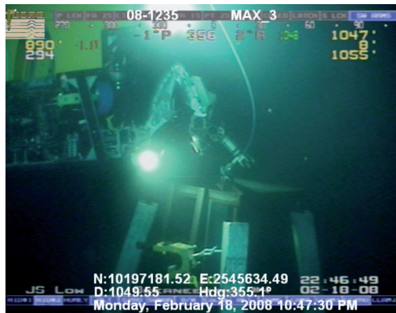
RetroPod 安装 ROV 将插座放入深水中并安装 RetroClamp。
