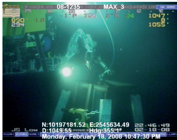
Installation d'un RetroPod
