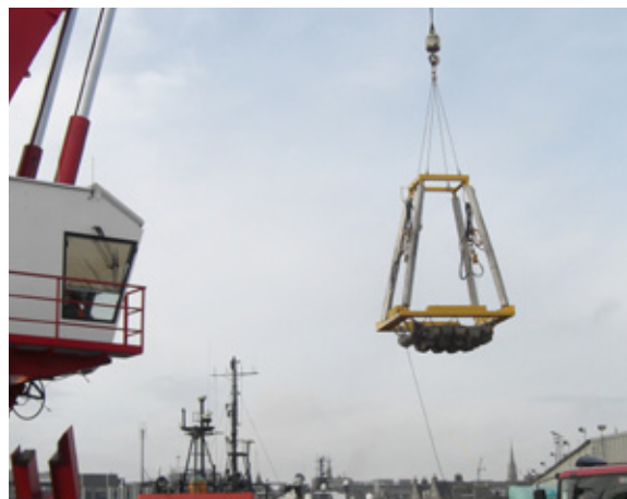
Mare del Nord Questo RetroPod è stato installato come parte di un retrofit sacrificale nel Mare del Nord.
