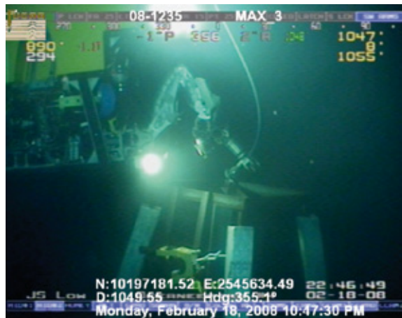
Deep-water production I ROV collocano un pod in acque profonde e installano le RetroClamp.
