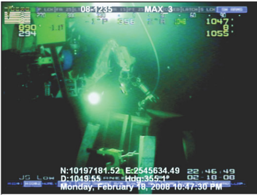
تركيب القضيب الخلفي تقوم المركبات المدارة عن بُعد بوضع قضيب في المياه العميقة وتركيب الخطافات الخلفية.
