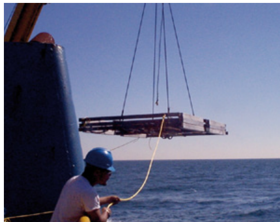
Guiné Equatorial O trilho expansível é enviado e implantado com 12 'x 8' e mede 40' na parte inferior.
